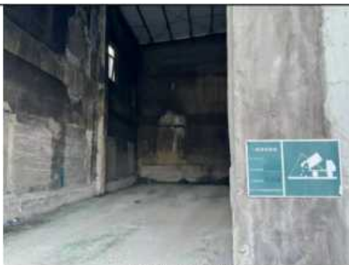
一般固废暂存间
